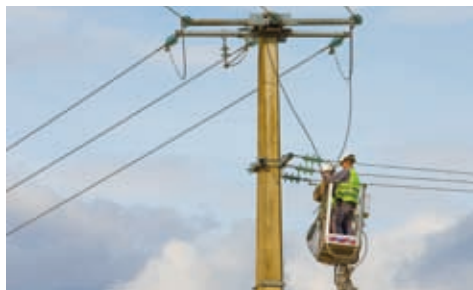
Installations de chantier - Thèze (64)
