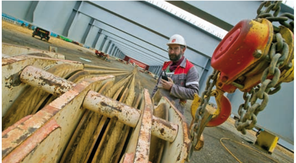
Lançage du tablier du Viaduc du Gabas
